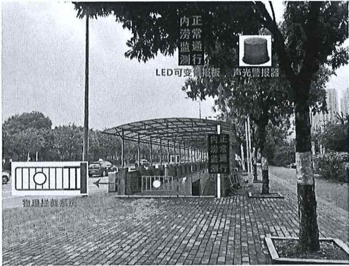
图 人行隧道洞口
