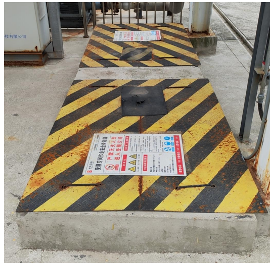
调节池 2、事故池 1
