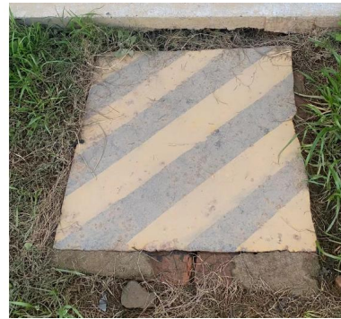
循环水排污井 1
