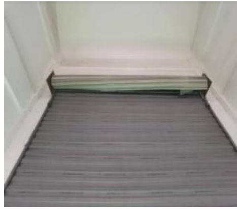
现场卷帘门外观
