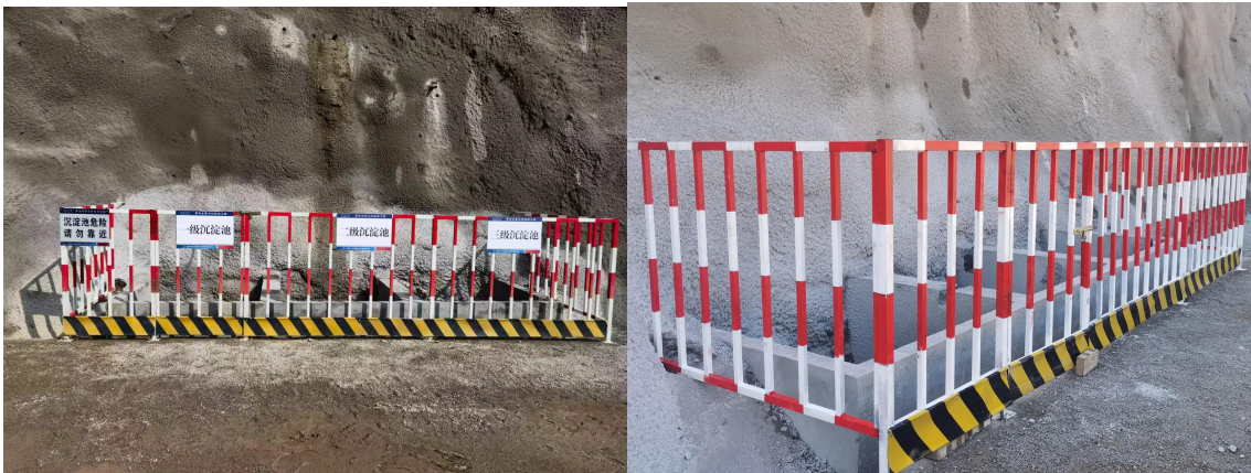
现场已建造三级沉淀池
