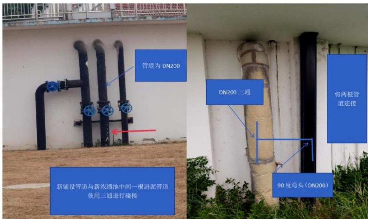
附图 2 新老管道连接方式
