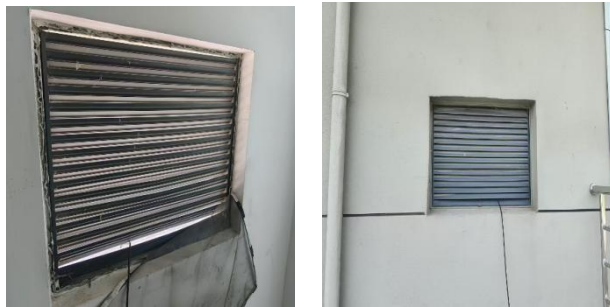
东侧百叶窗内部、外部
