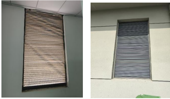
西侧百叶窗内部、外部
