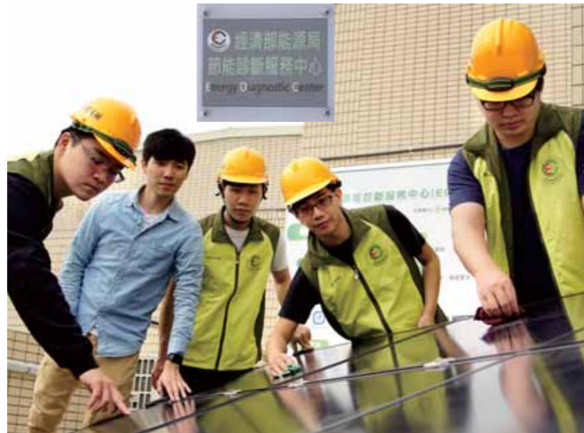
▶ 太阳能发电效能诊断 ◀
