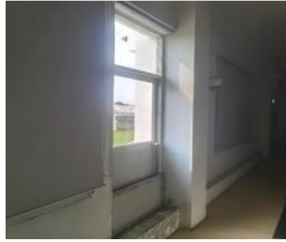
现场安装区域
