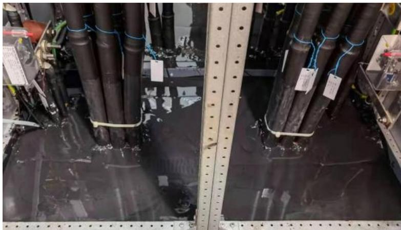
图 3 柜体防潮绝缘封堵材料现场应用图片
