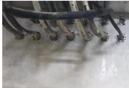
图 4 电缆管道防护密封塞样品
