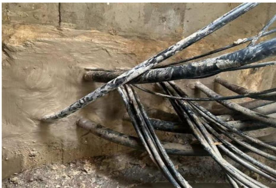
图 2 柔性封堵泥现场应用图片
